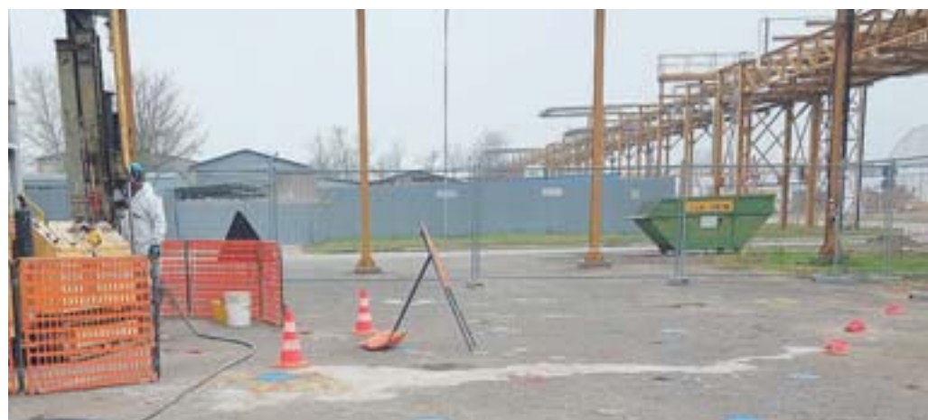
La pompa di iniezione e i punti dove viene utilizzata: i colori rossi e blu indicano le aree di minore e maggiore concentrazione di cromo esavalente all'interno del polo chimico
